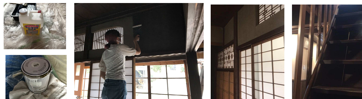
Figure 6 土壁のシーラー処理と移設階段
