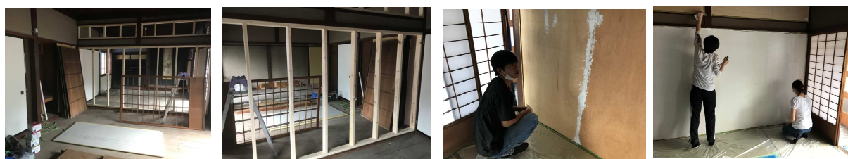
Figure 4 客室間仕切り壁工事
