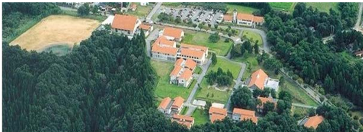
写真 1 富山国際大学とその周辺の上空写真
