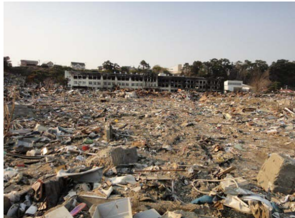
津波と火災で大きな被害を受けた門脇小学校
