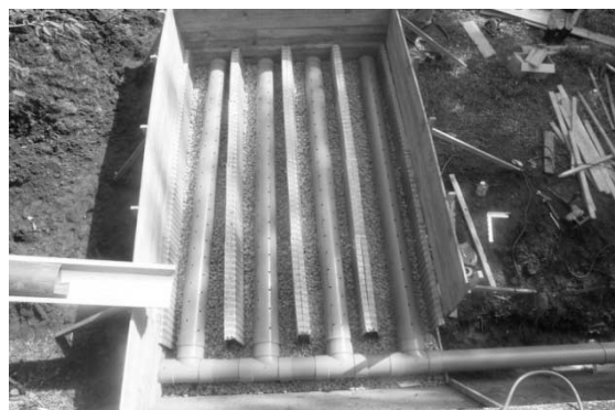
図-3 浸透取水装置の内部構造
