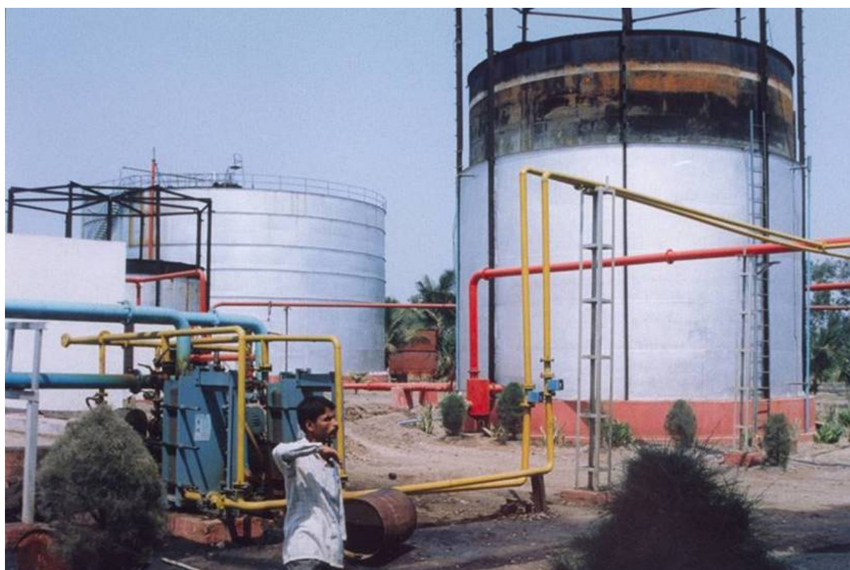
写真1 インドにおけるサトウキビ廃液のメタン発酵（中央奥のタンク）によるメタンガス生産
