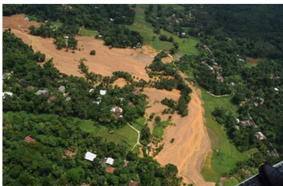
写真3 土砂崩れ現場の上空写真
